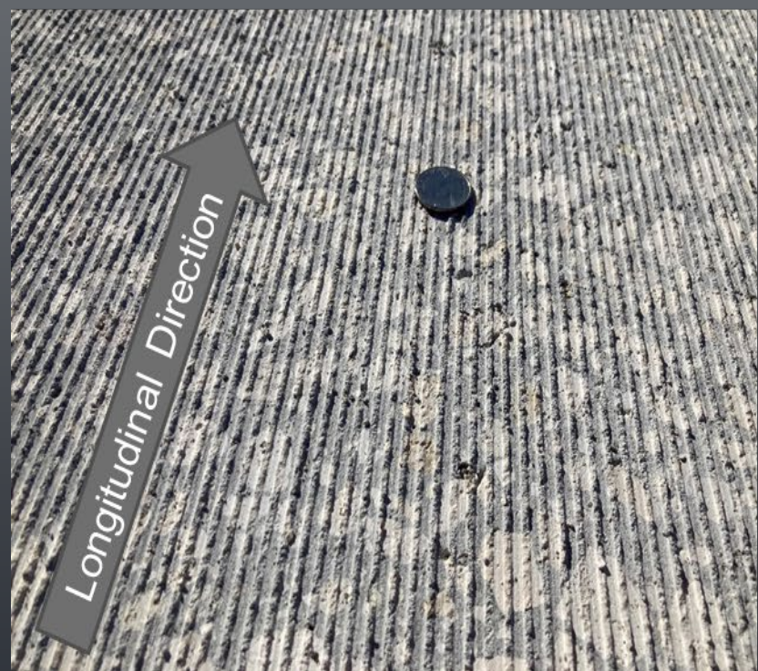
Longitudinal Diamond Grind (LDG)
